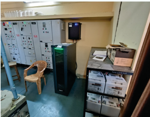
आकृति 46. 40-इंच कोटिंग प्लांट में स्थापित 30kVA UPS और नियंत्रण पैनल।
